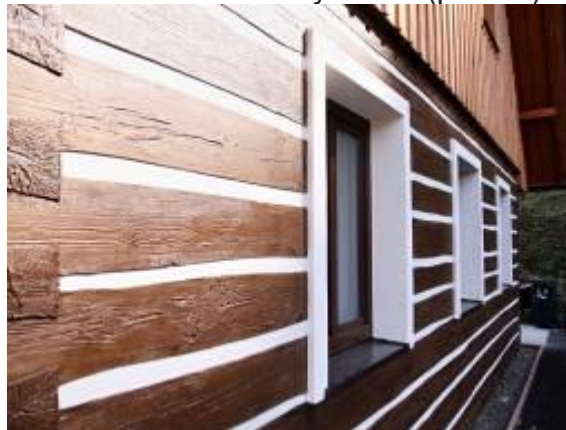
Obr. 14 – Šambrány rovné (plocha)
