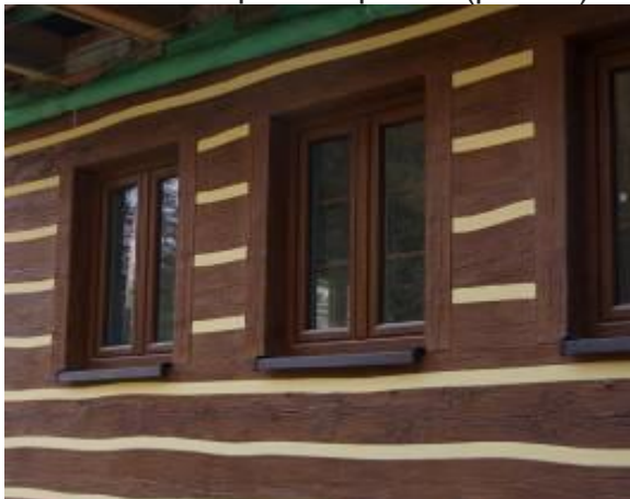
Obr. 6 - Sloupková špaleta (plocha)
