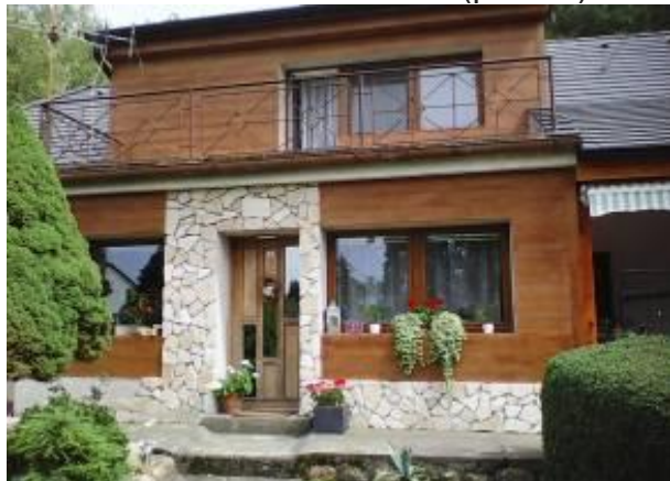
Obr. 7 – Moderna – bednění (plocha)
