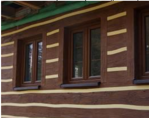
Obr. 6 - Sloupková špaleta (plocha)
