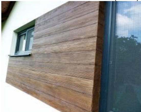
Obr. 8 - Moderna – bednění (detail)
