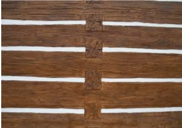
Obr. 3 – Zakotvení příček
